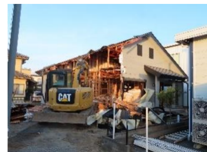
解体中の様子
